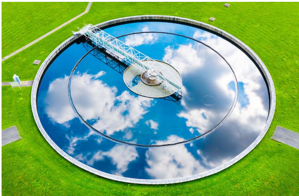
Vue aérienne d'une station d'épuration. Recyclage des eaux grises (© iStock).
